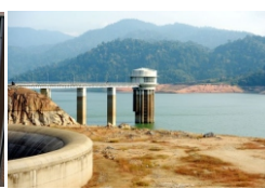
Captação de água para tratamento
